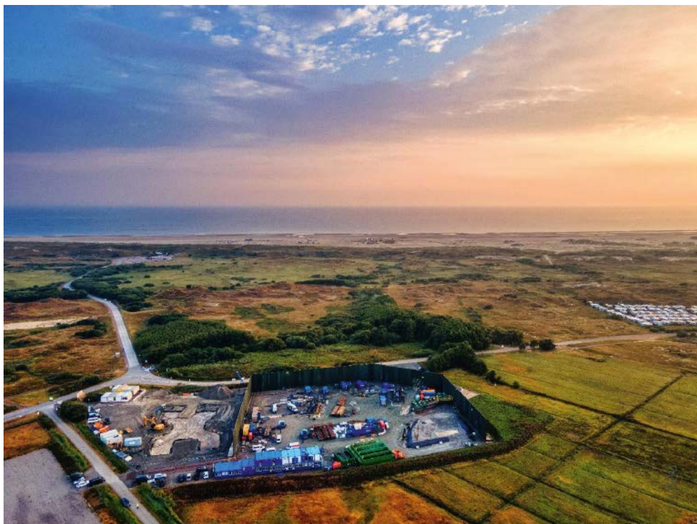
Aufnahme aus dem August 2022: links im Bild die Baustelle der Kabelinstallation DolWin6 und rechts die Baustelleneinrichtungsfläche für die HDD-Bohrungen BD4 auf Norderney (Blickrichtung Norden) (Fotograf: Martin Pohl, Ney360°)
